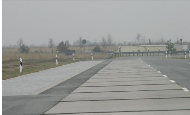
Abbildung 16 Betonstöße und Kleinpflaster
