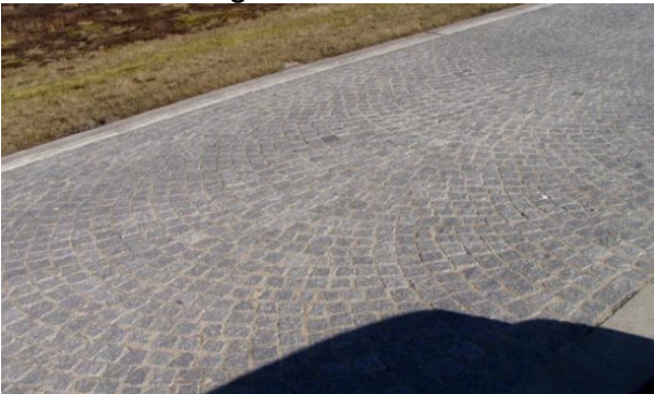
Abbildung 17 Kleinpflaster Detail
